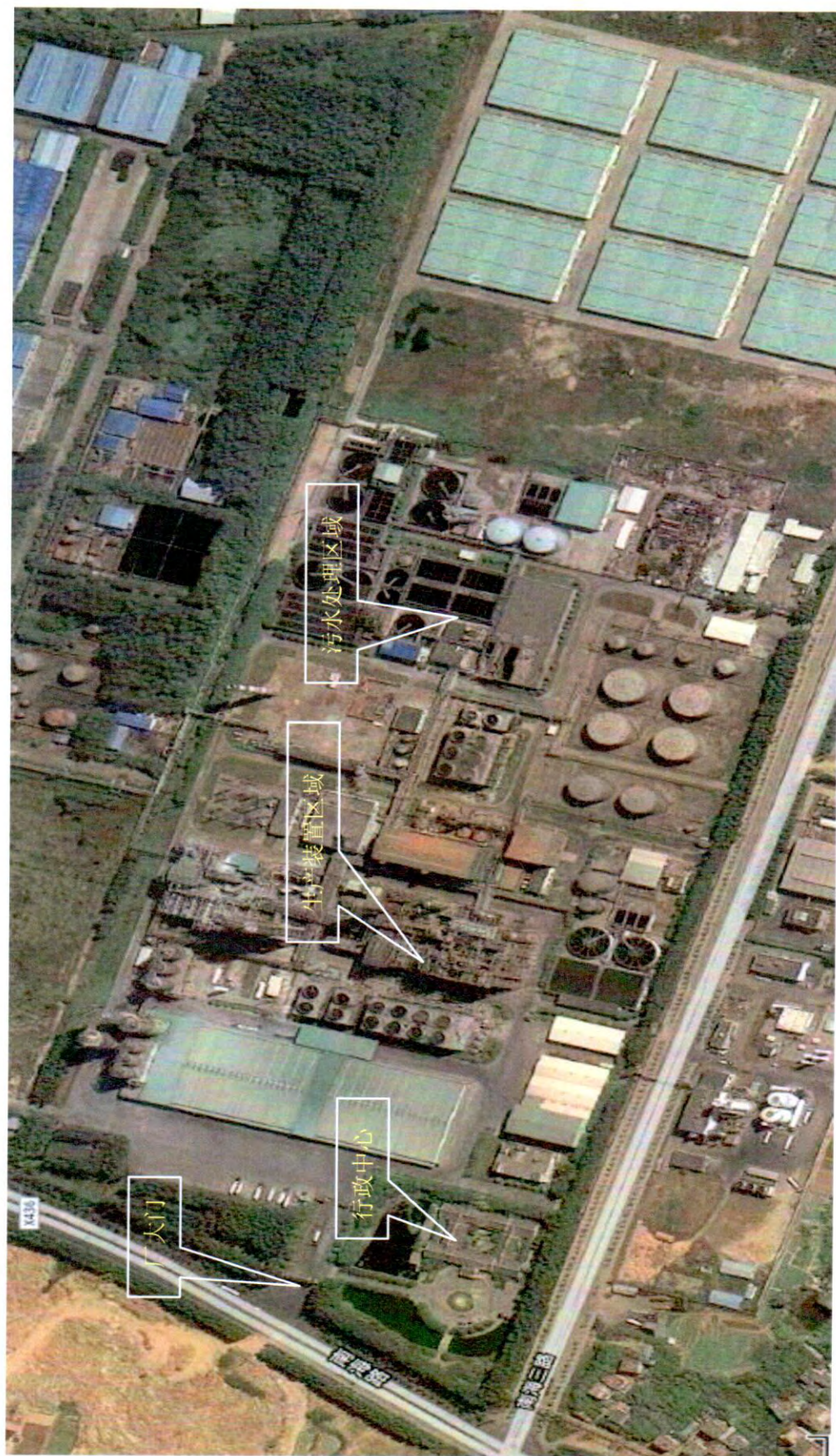
图 3-4 厂区平面布置实景图（卫星俯视图）
